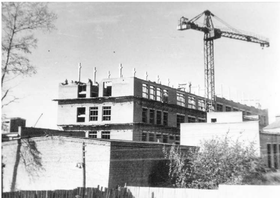
Строительство заводского цеха, 1963 год
