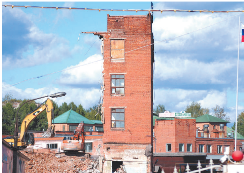
Разрушение заводского цеха, 2016 год
